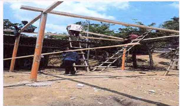
Foto 4 : Cambio de madera completa de la cocina de la EORM Caserio Chioyal.
