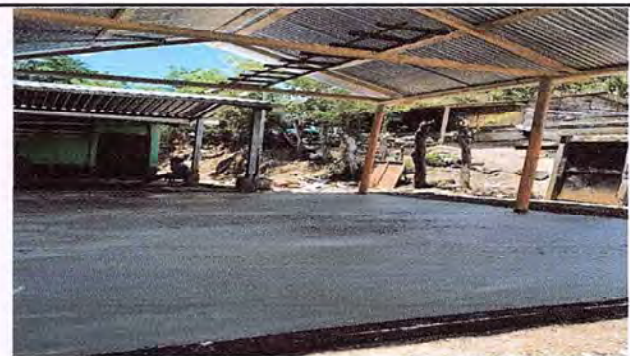
Foto 6: Entortado del interior de la cocina de la EORM Caserio Chioyal
