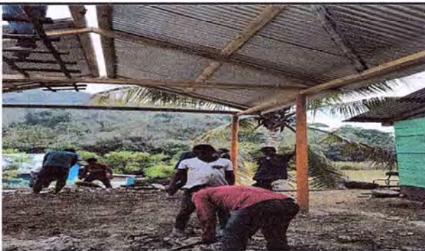
Foto 5: Nivelacion de la tierra en el interior de la cocina de la EORM Caserio Chioyal.
